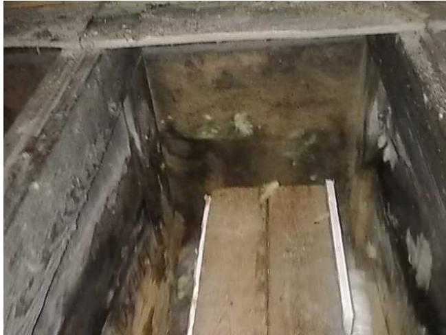
Asuntojen välisen seinän kohta yläpohjassa.
