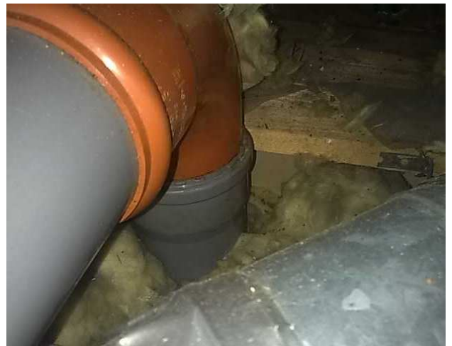
Putkiläpiviennit yläpohjassa
